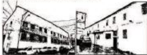
Foto 7 - Fachada frontal a interior.
