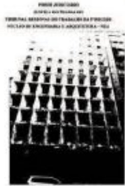
Foto 2 - Fachada de acero.
