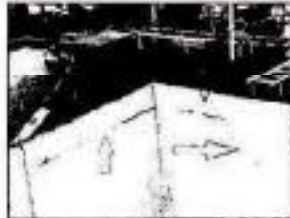
Foto 8 - Fichaje en fachada con trazo de punto de partida.
