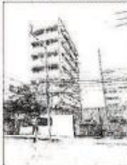
Foto 2 - Fachada de muros.
